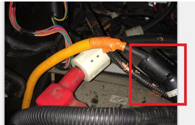
蓄电池充电连接线整改后照片
